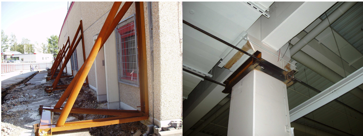
Rys. 7. Doraźne zabezpieczenia konstrukcji; podstemplowanie ściany, ściagi w górnym poziomie słupów
