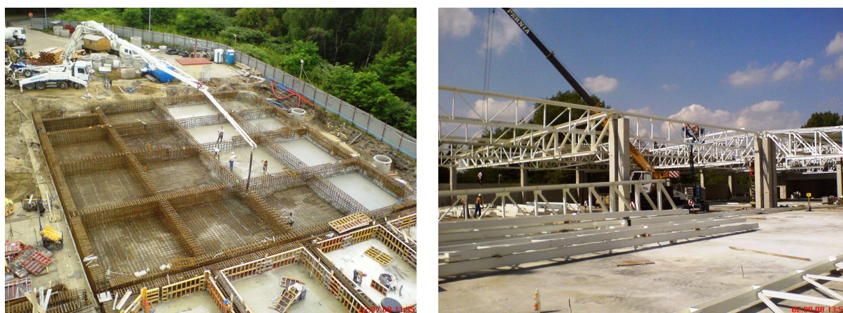
Rys. 10. Odbudowa obiektu; betonowanie rusztu fundamentowego, stalowa konstrukcja dachu
