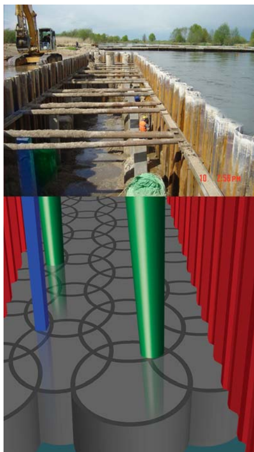
Fot. 7 Posadowienie mostu na Warcie - wykop z widokiem na pale
