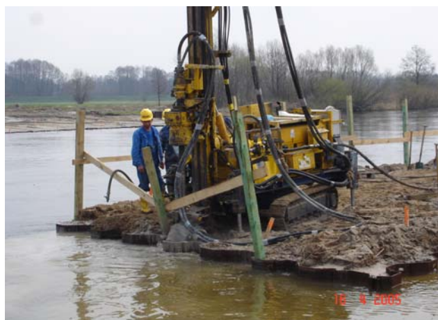
Fot. 7 Posadowienie mostu na Warcie - wykop z widokiem na pale
