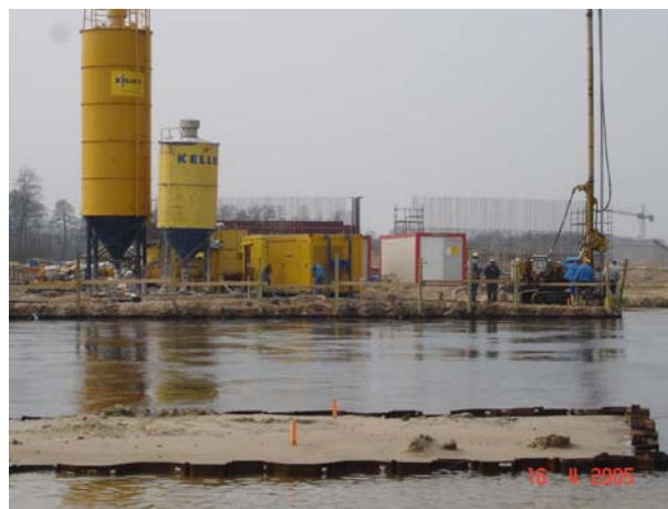
Fot. 6 Posadowienie mostu na Warcie - widok na obie podpory mostu przy wysokim stanie wody
