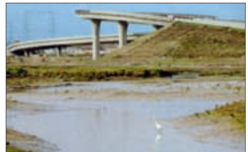
Wzmocnienie gruntu pod przyczółkiem za pomocą kolumn CMC.
