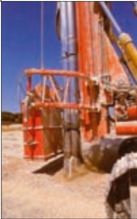
Kolumny kamienne z podawaniem materiału „od dołu”.
