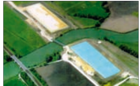
Konsolidacja metodą próżniową podłoża pod nasypy prowadzące na most na rzece Boutonne. Autostrada A537 (Francja).
