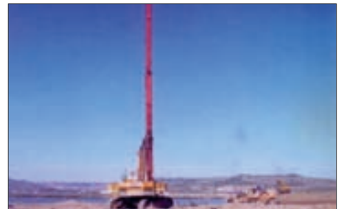
Instalowanie drenów pionowych o długości 25m w glinach na trasie drogi ekspresowej Rabat-Larache (Maroko). Konsolidacja nasypów drogowych wspomagana poprzez wstępne obciążanie.
