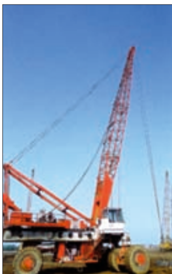
Maszyna do zagęszczania dynamicznego o energii 700 t x m konstrukcji Menarda.
