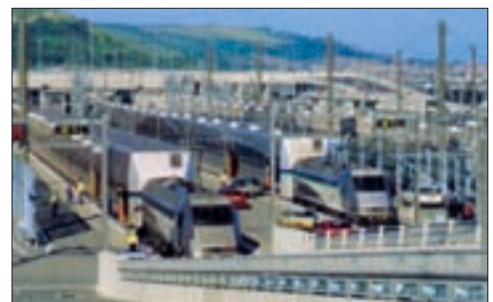
Wzmacnianie podłoża poprzez konsolidację próżniową na terenie stacji Eurotunelu w Coquelles (Francja). Widok po wybudowaniu stacji.
