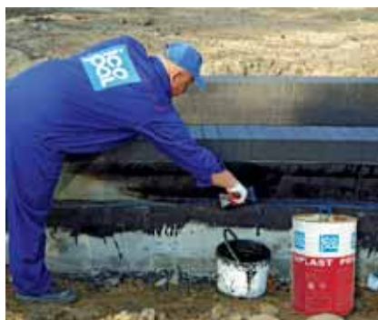
Gruntowanie ścian fundamentów Siplast Primerem®
