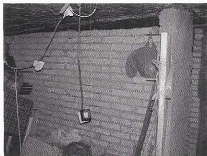
Fot. 1. Oddzielenie ścian działowych od stropu w piwnicach
