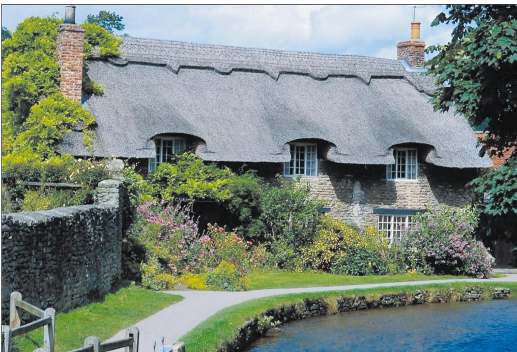
NAJWIĘKSZE TRUDNOŚCI POWSTAJĄ PRZY WYMIANIE STARYCH FUNDAMENTÓW NA NOWE
